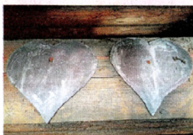
Zajímavý nález Oprava střechy bývalé věznice se dělala z vysokozdvizné plošiny. Dole cedulky pokrývačů z Břestku. Foto: ÚZSVM
